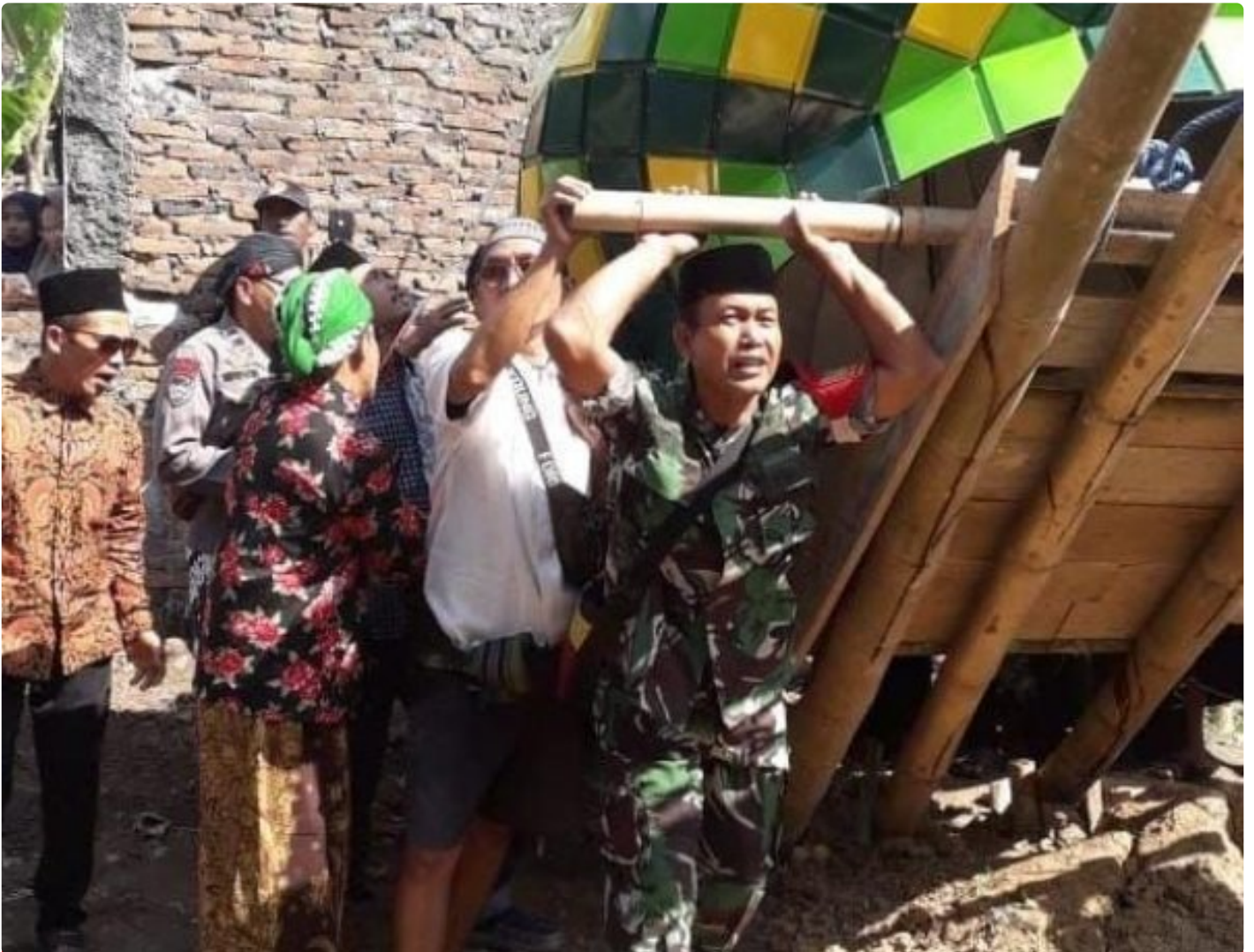
Babinsa Bersama Bhabinkamtibmas Desa Rejosari Membantu Warga, Saat Pemasangan Kubah Masjid At-Taqwa di Dusun Bakalan Desa Rejosari Kecamatan Bandongan
