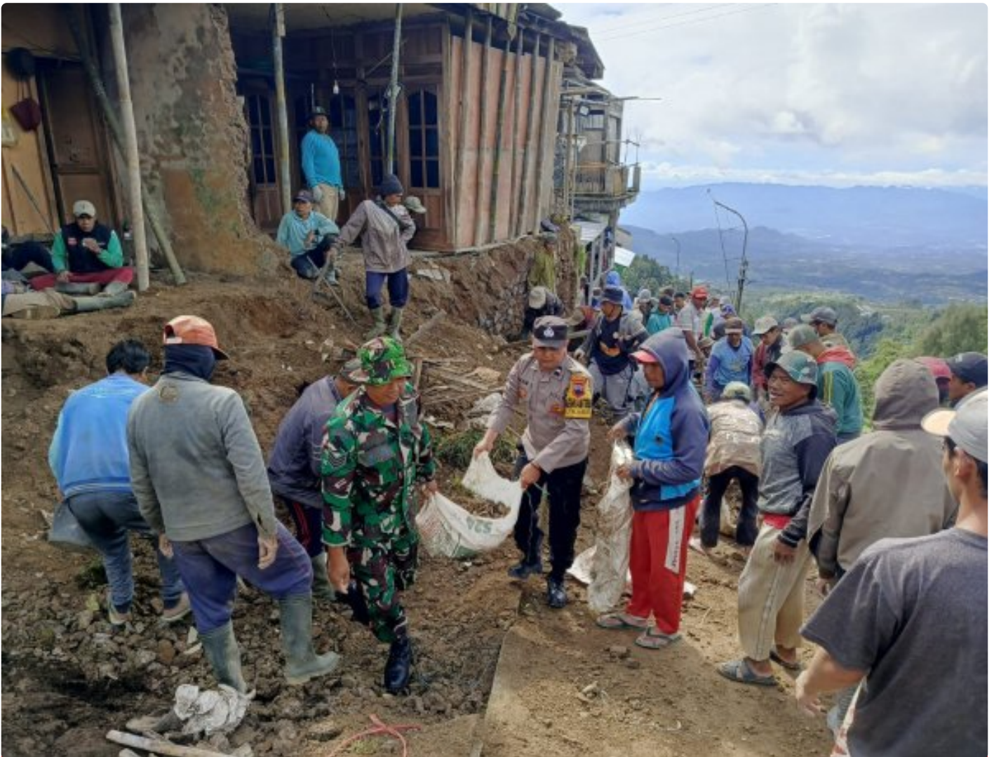
(Foto Dokumen) : Gotong royong pembersihan material longsor
