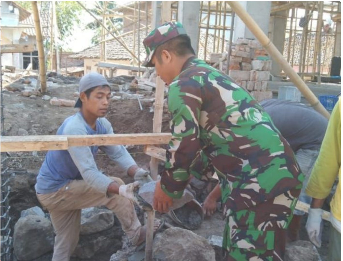
Serda Nasikin bantu pemasangan batu pondasi masjid
