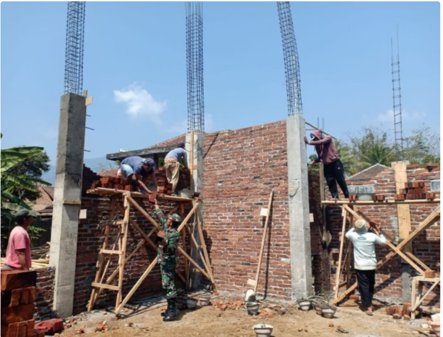
Anggota Koramil 04 Windusari Serda Nasikin kerja bakti bantu pembangunan Masjid
